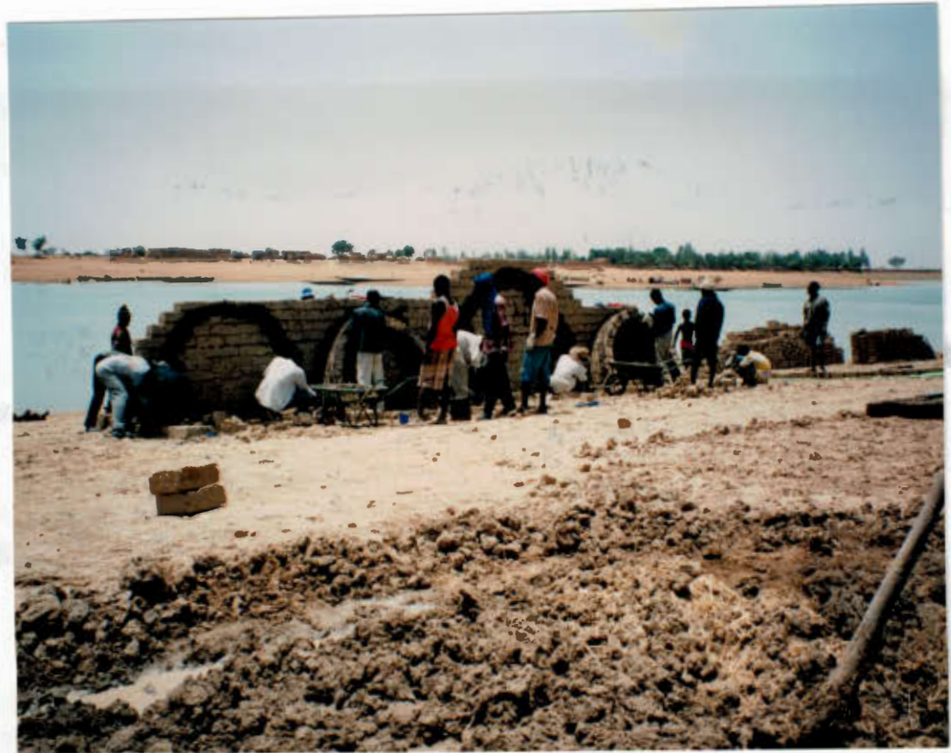
AU BORD DU FLEUVE NIGER, INITIATION A LA CONSTRUCTION DES VOUTES
